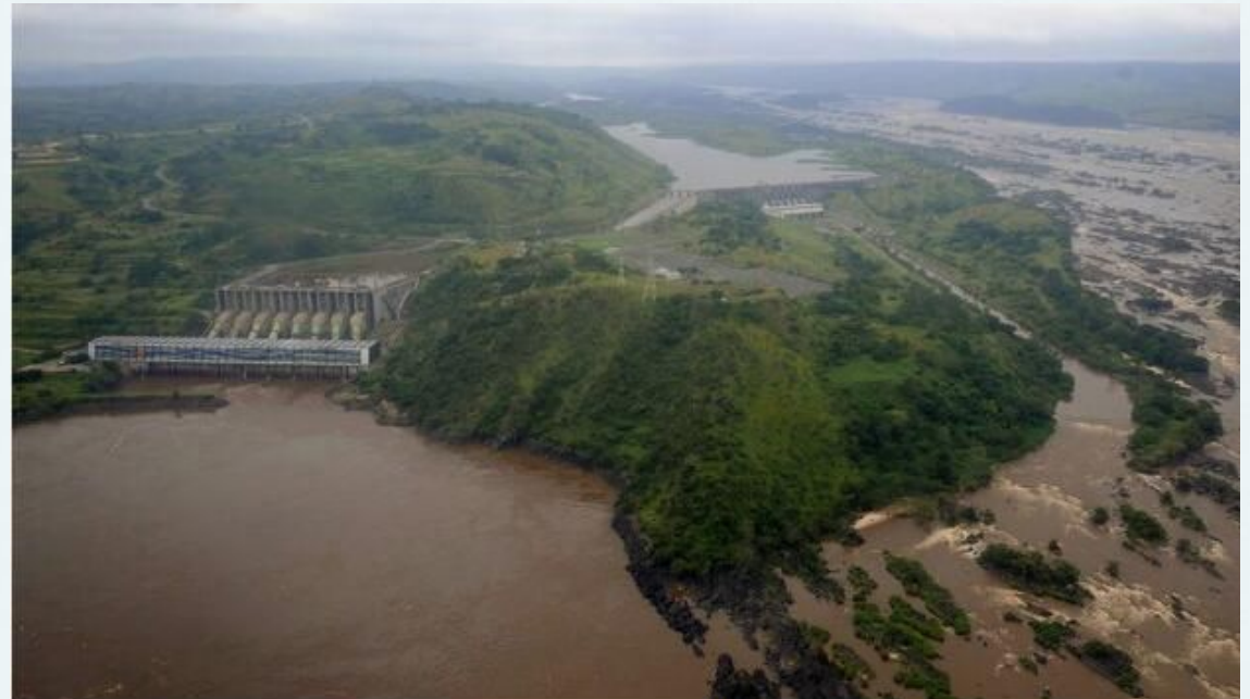
Der Kongo-Fluss mit den beiden existierenden Inga-Staudämmen. Inga III wäre zehnmal größer Foto: Thierry Charlier / Camera Press / laif
