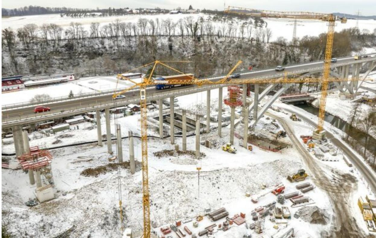
Die Brückenpfeiler wachsen in die Höhe und lassen erkennen, dass das zweite Murrthalviadukt ein Zwillingbauwerk zur bestehenden Brücke wird. © Benjamin Beytekin
